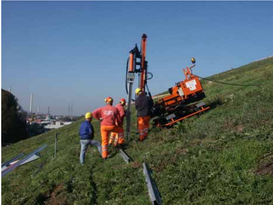
Abb. 9: Rammen der Pfosten für die Modultische
